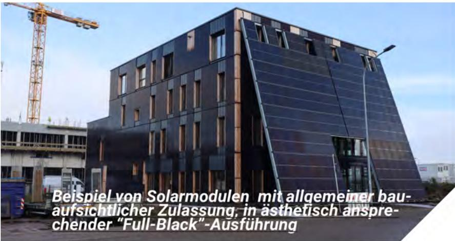
Beispiel von Solarmodulen mit allgemeiner bauaufsichtlicher Zulassung, in ästhetisch ansprechender "Full-Black"-Ausführung
